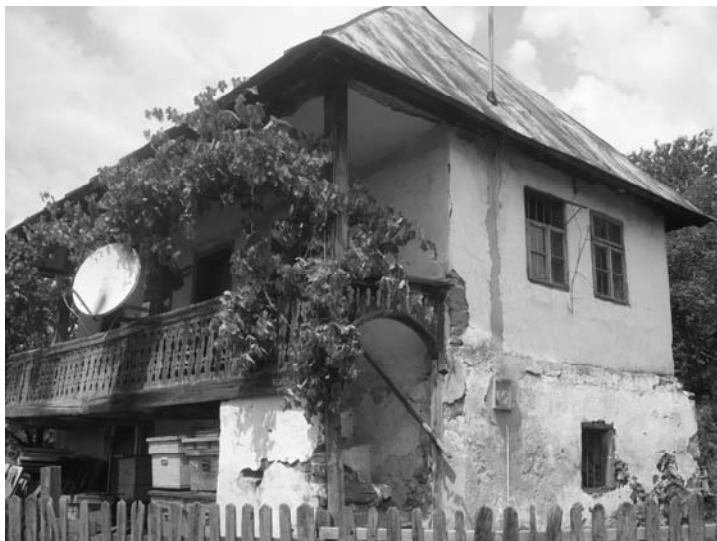
Fig. nr. 1 Casă înălțată pe soclu de cărămidă – sat Tisa, orașul Băile Olănești, jud. Vâlcea (foto 2012)
